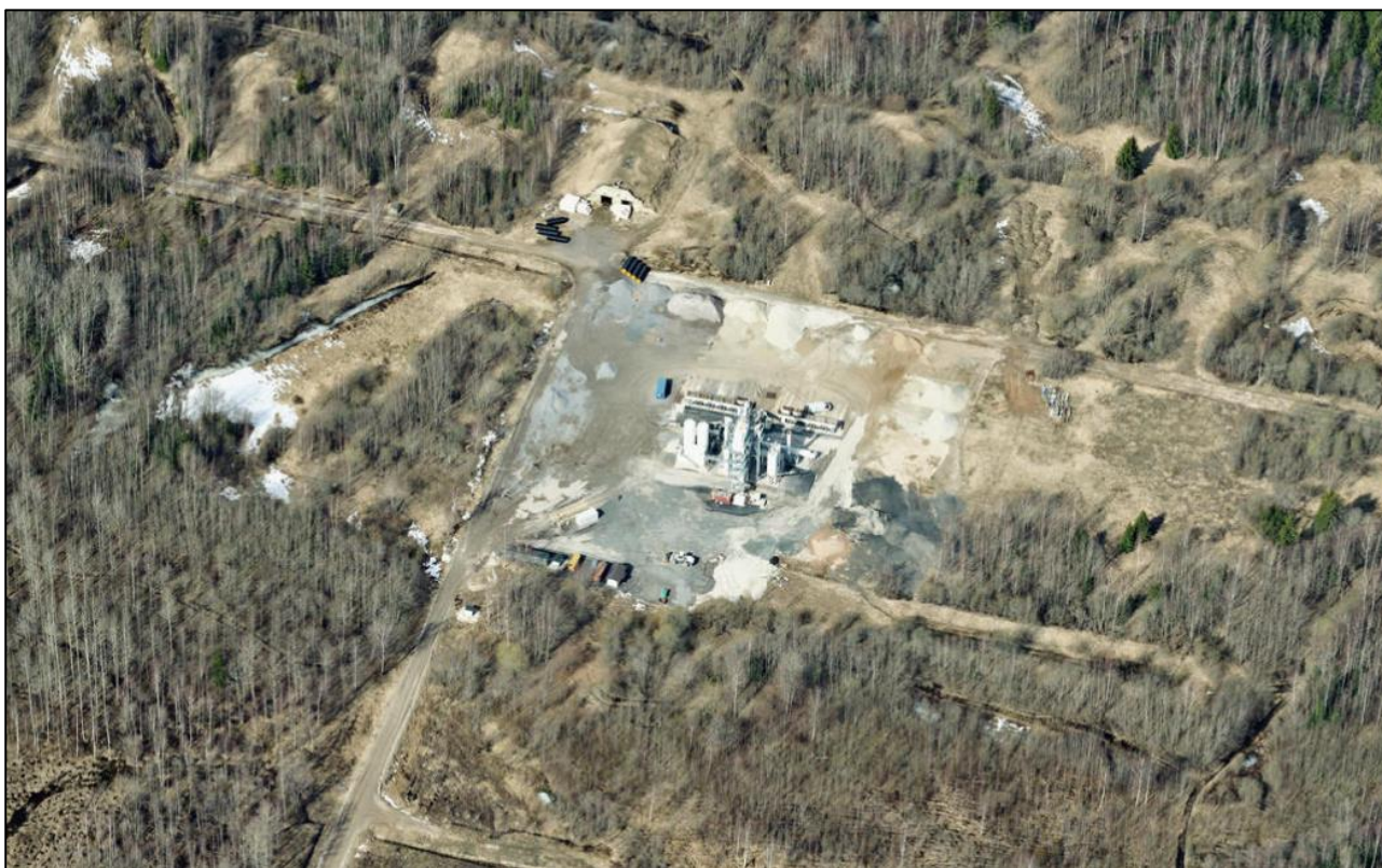
Joonis 27. Asfaltbetoonisegisti asukoht pärast alustarindi rajamist ja segisti paigaldamist (Maa-ameti fotoladu, pildistamise aeg: 13.04.2022)
