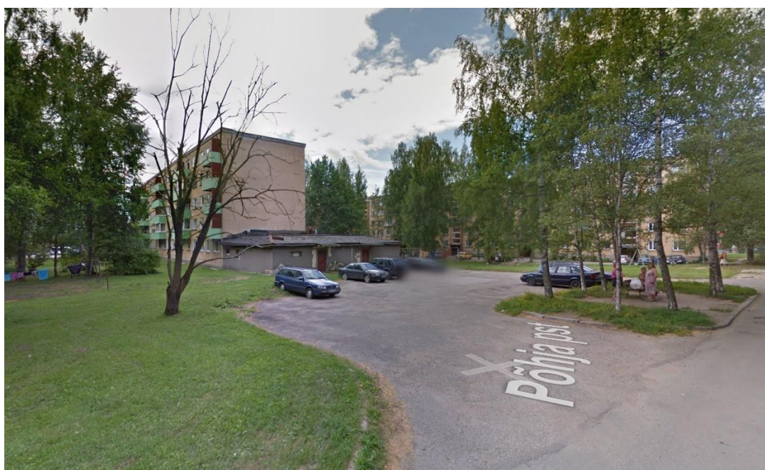
Google street view väljavõte olemasolevast olukorrast juuli 2014
