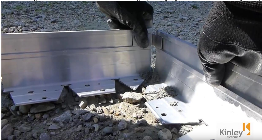
Pilt 3. Nurga konstrueerimine kinnitusribadega (Kinley Systems kodulehelt väljavõte)
