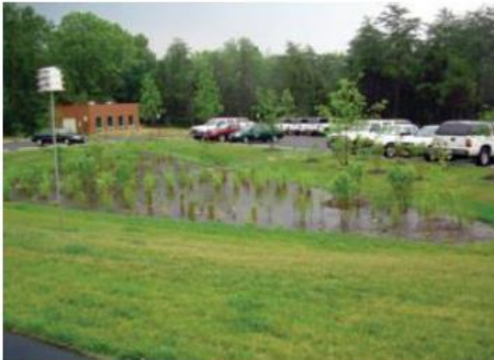
Joonis 3.36. Biopuhver (allikas: Infragate Eesti AS, 2016).
