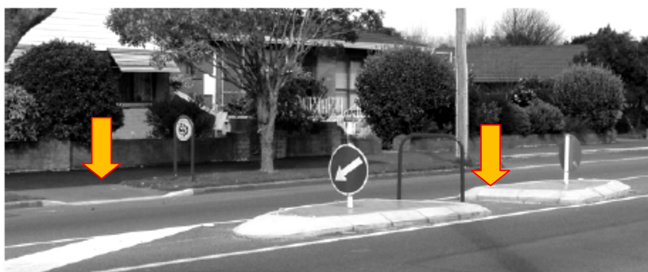
Fotot 3.3.1.3: Kergliiklejale on tagatud sujuvad üleminekud tänavatasapindade vahel, sh ohutussaare ületamine tasapinna muutuseta. Allikas: „Pedestrian planning and design guide“, Land Transport NZ, 2007
