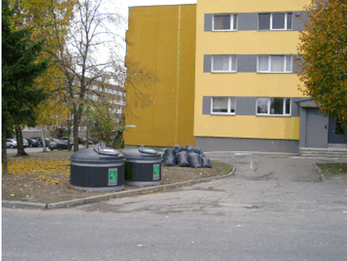
Linna toel paigaldatud süvakogumismahutid Kaunase pst 19
