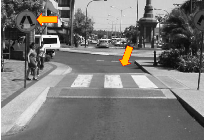
Foto 3.3.1.2: Tõstetud ülekäigurada kombineerituna mootorsõidukijuhte hoiatavate märkidega. Ühtlasi toimub kergliikleja liikumine samal tänavatasapinnal – liikumine on häiringuta ja sujuv. Allikas: The Local Government & Municipal Knowledge Base, Igam.wikidot.com.
