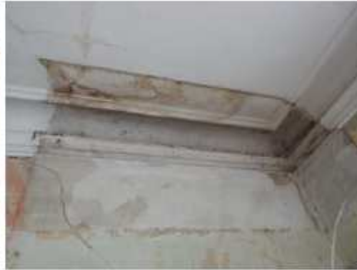
Kunagine läbijooksu koht
