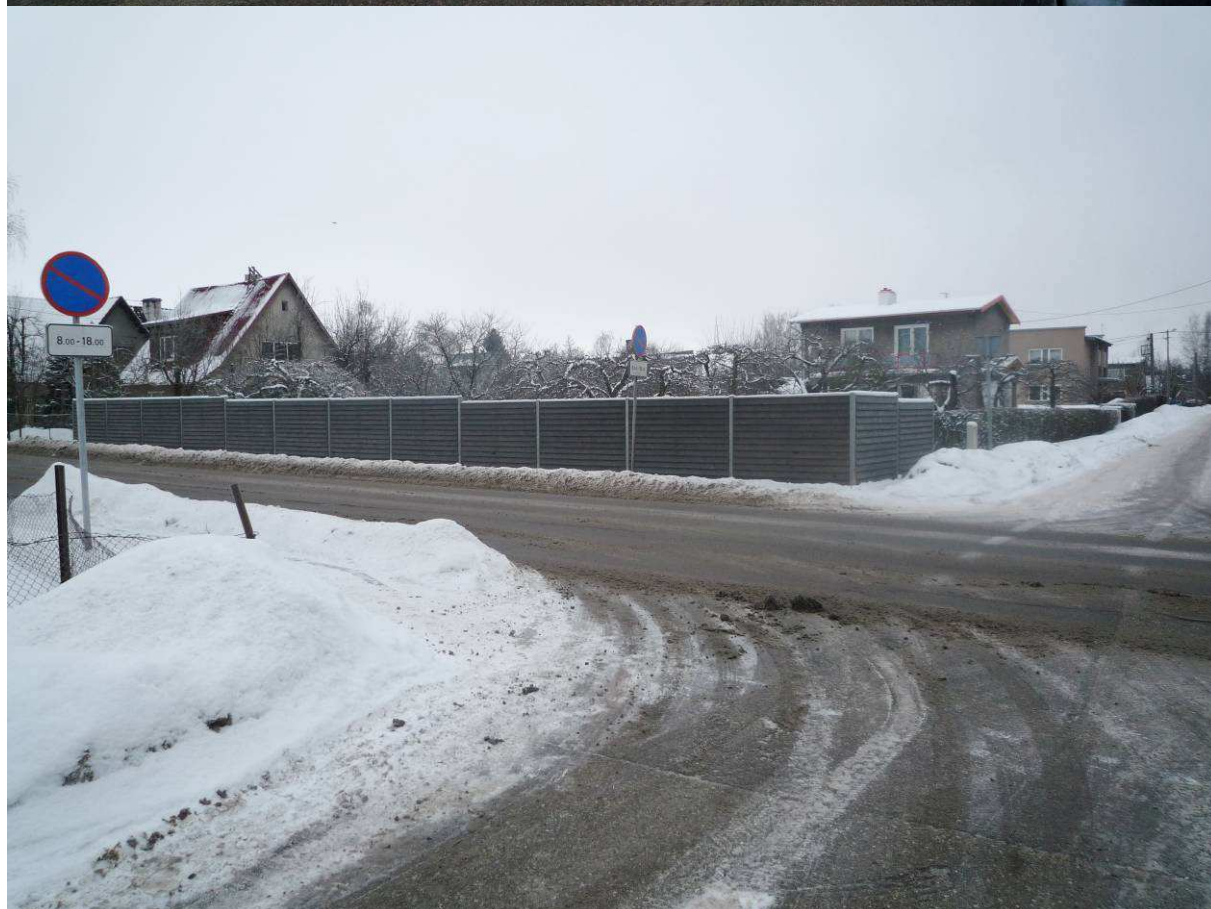
Fotod 6.3. ja 6.4. Aardla tn elamukruntide kaitseks rajatud 1,5-2 m kõrgused piirded.
