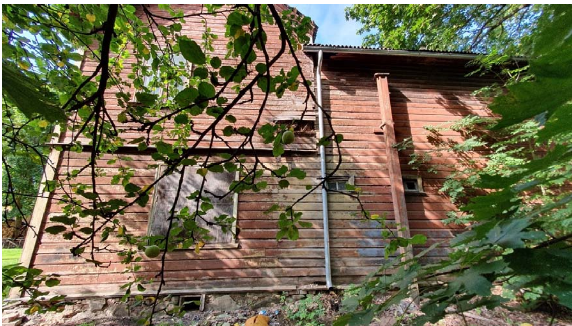
Pilt 28. Näituse tn 6 elamu tagakülg, vaade kirdest, Näituse tn 2a krundi poolt. Hoone on kasutuseta, kuid tänu katusele, remonditud rennidele ja vihmaveetorudele on pöördumatu ehituslik kahju ära hoitud. Autor: Mart Hiob 2019.
