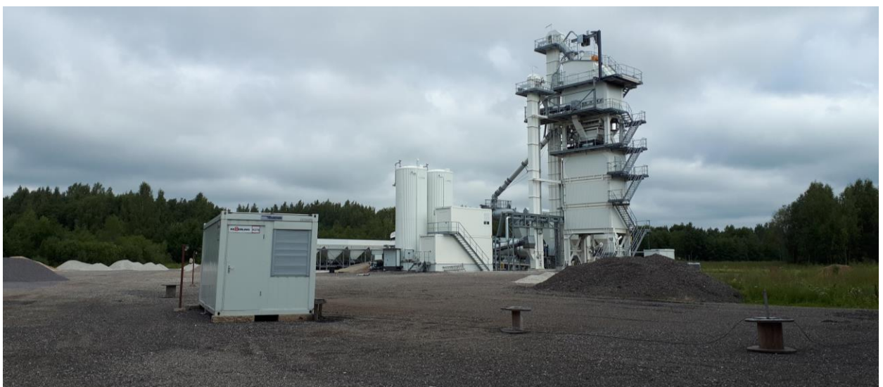
Foto 2. Olemasolev asfaltbetoonisegisti. (Allikas: Maris Palo erakogu)
