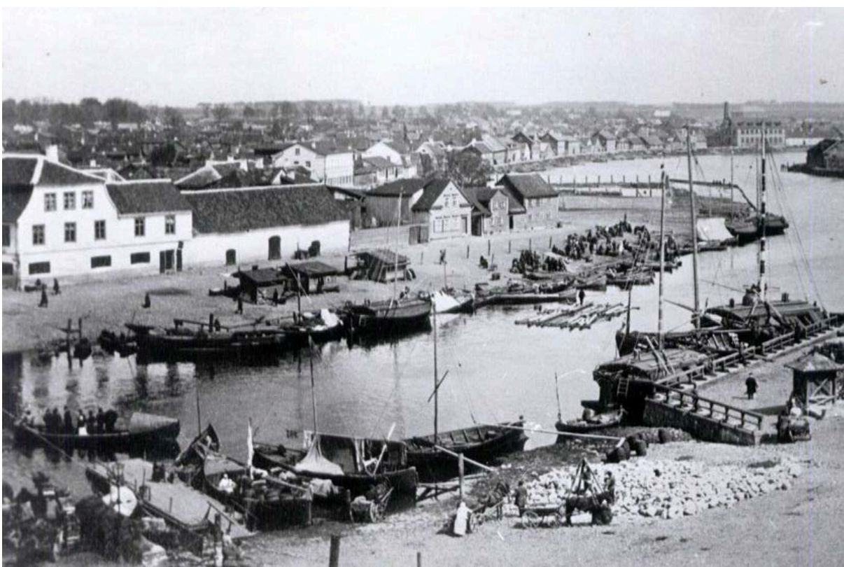
Pilt 31. Planeeringuala 19. sajandi fotol, esiplaanil Emajõe paremkallas. Vasakul servas Holmi tänava ots Holmi tn 26 majaga, jõe ääres Kalaturu tänava kaldapealne hoonestus ja müügiputkad. Pildistatud pitsimaja tornist.
