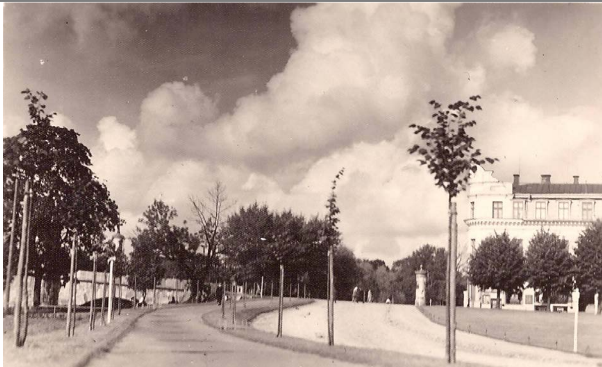
Pilt 111. Heakorrastatud endine heinaturg planeeringualal 1930ndate lõpu fotol. Paremas servas paistab Belle Vue hotelli hoone.
