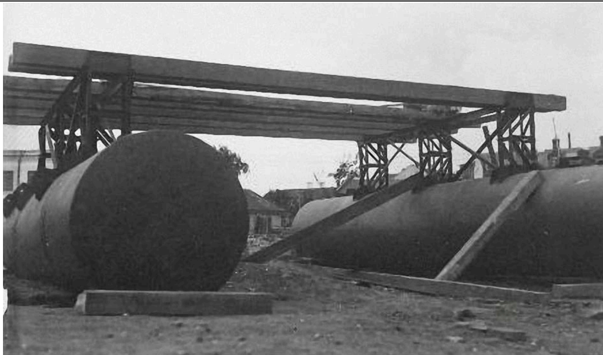
Pilt 115. Fortuuna ja Lodja tänava vahele ehitatud ujuksilla ujukite monteerimine 1933. a K. Kalamehe fotol.
