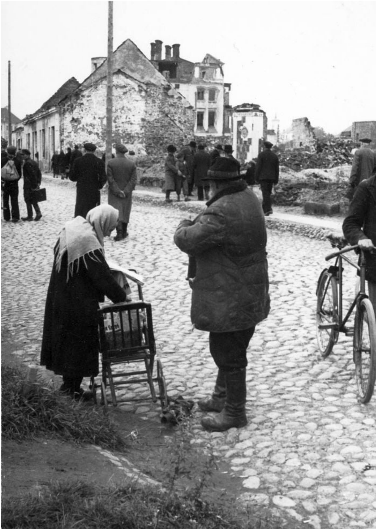
Pilt 127. Varemed Kalaturu tänavas 1940ndate fotol. Püsti on Holmi tn 26 müürid ja selle taga hotelli Jakor vare.
