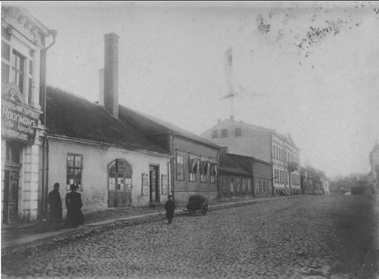
Pilt 30. Holmi tänava keskpaik 19. sajandi fotol. Esiplaanil vasakus servas uhkema kujundusega kahekorruseline kivimaja aadressiga Holmi tn 4, tagapool väiksemate majade järel kahekorruseline Franz Georg Faure tööstuse kahekorruseline kivimaja aadressiga Holmi tn 12. Allikas: EFA.197.0.29384.
