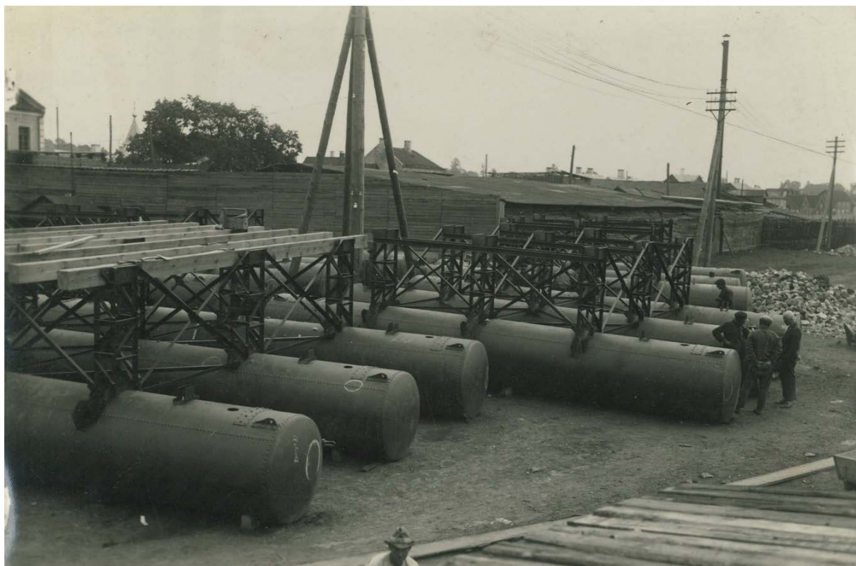
Pilt 116. Fortuuna ja Lodja tänava vahele ehitatud ujuksilla ujukite monteerimine 1933. a fotol.
