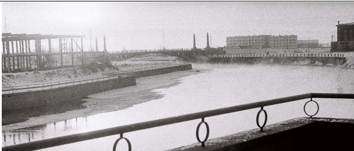
Pilt 164. Restorani Kaunas hoone ehitus planeeringualal Emajõe vasakkaldal 1960ndate keskpaigas või teises pooles. Jõekallas on kindlustatud betoonrinnatisega.
