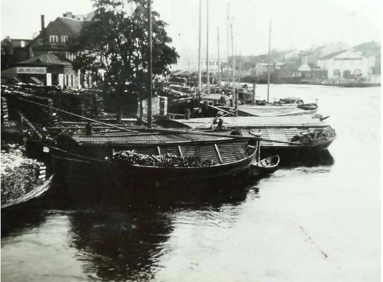
Pilt 54. Vasakul planeeringuala 20. sajandi alguse fotol. Esiplaanil lodjad küttepuukoormaga ja jõeäärse hoone otsasein kalaturu ääres. Paremäl Emajõgi ja paremkaldal hotell Narva.
