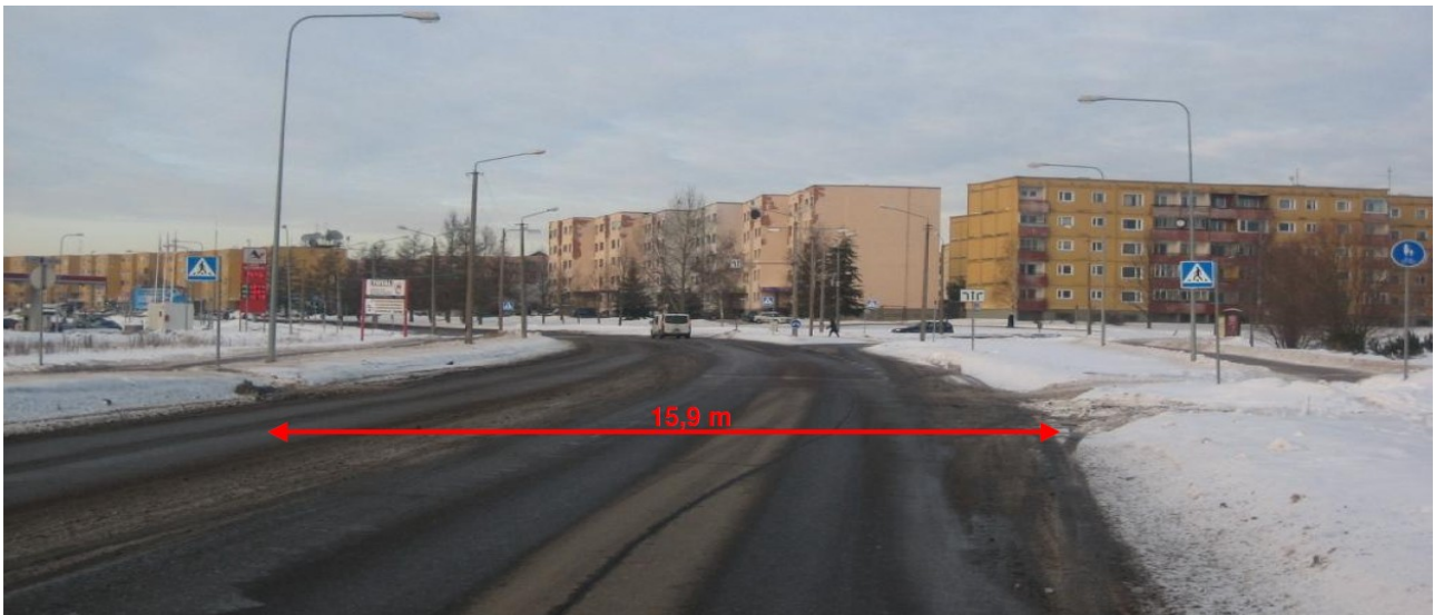
Lammi tee ülekäigurada. Käimas Mõisavahe - Lammi tee - Kalda tee ristmiku rekonstrueerimine.
