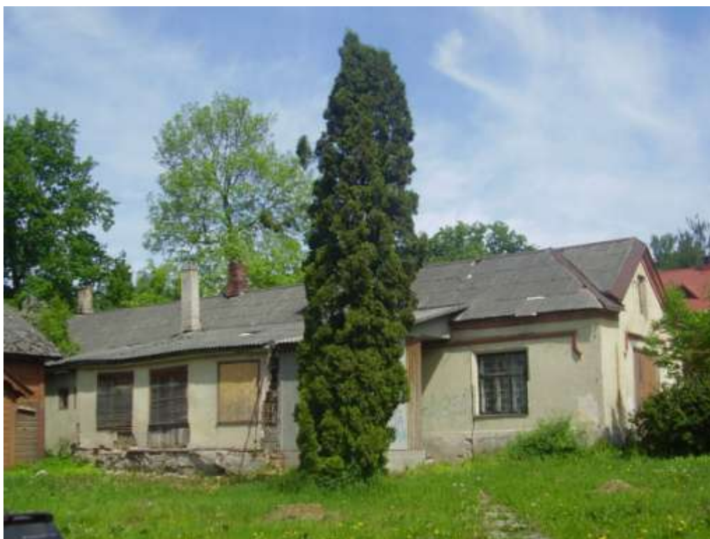
Foto 8. Bakterioloogiajaama hoone (vaade hoovi poolt). Foto J. Veskimeister, 2009
