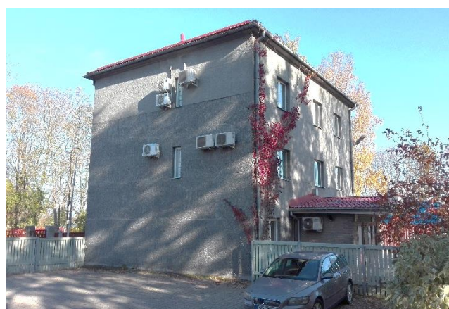
4. Vaade Kitsas 8 lääne- ja lõunafassaadile
