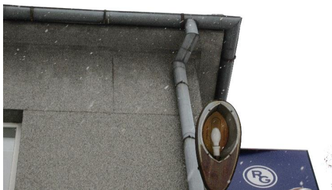
9. Terrasiitkrohviga kaetud räästakarniis
