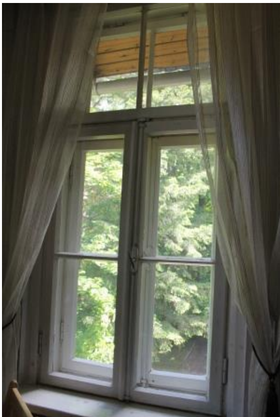
Fotod 20 ja 21. Aken A75, millel on säilinud algupärsed puitraamid ning välise raami kreemoon (sisemine krmoon on uuem).
