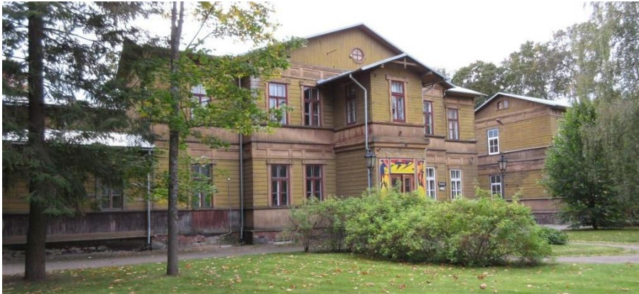
Foto 1. Vaade Staadioni tn 48 hoone esifassaadile.
