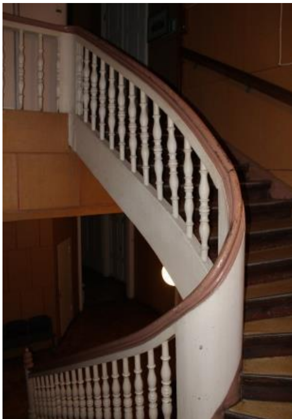
Foto 23. Säilinud algupärane puidust peatrepp
