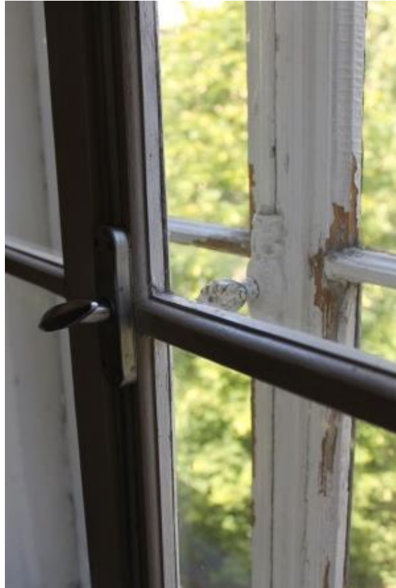
Fotod 20 ja 21. Aken A75, millel on säilinud algupärsed puitraamid ning välise raami kreemoon (sisemine krmoon on uuem).
