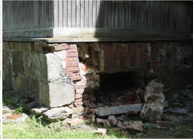
Fotod 11 ja 12. Kahjustused hoone fassaadi laudisel ja vundamendis.
