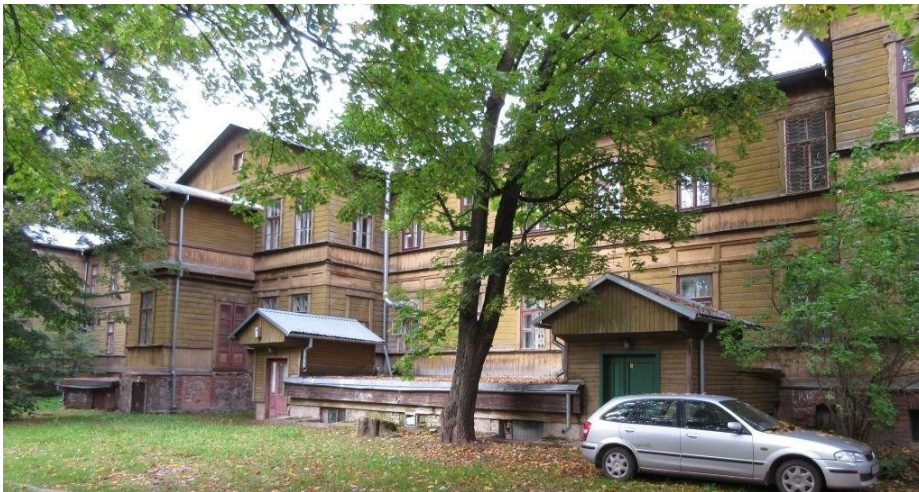
Foto 2. Vaade Staadioni tn 48 tagafassaadile.
