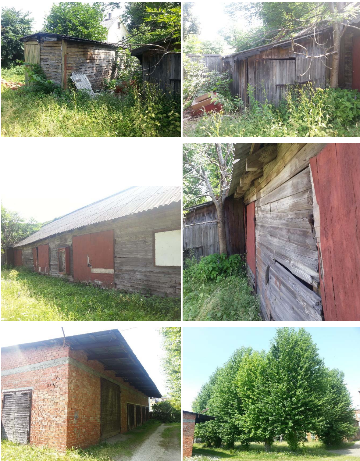
Joonis 8. Tiigi tn 78/80 krundi kagunurgas paiknevad abihooned (järjestusega ida suunast läände): üks alla 10 m 2 suurune kuur (ülemine pahempoolne pilt), puitsõrestikus eterniitkatusega 135 m 2 suurune kuur-garaaž (ülemine parempoolne ja keskmised pildid) ning punastest kärgtellistest raudsarikatega 214 m 2 suurune garaaž alumine (parempoolne pilt). Krundi lõunaosas asuvad täiskasvanud paplid (alumine parempoolne pilt).
