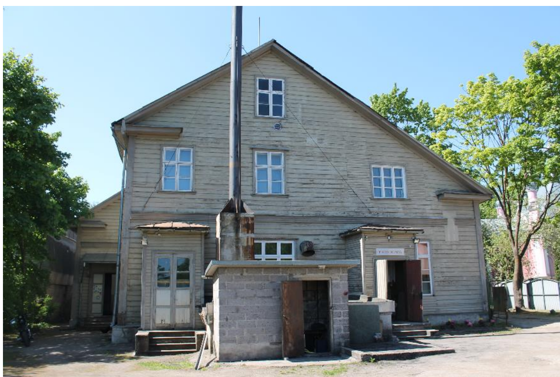
Foto 13. Vaade hoone hoovipoolsele ehk idafassaadile. Parempoolse 6-ruudulise akna A40 asemel oli algselt kaks 6-ruudulist akent. Laudises on näha algsete akende kohad. 1947. ja 1960. aastate vahel ehitati ka välisuks VU4 (paremal) ning välisuste VU3 ja VU4 tuulekojad.
