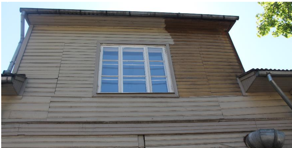
Foto 19. Vaade põhjafassaadi teise korrusel asuvale aknale A39. Algselt oli ühe 9-ruudulise akna asemel kaks 6-ruudulist akent, mille paiknemist on siiani laudisel näha.
