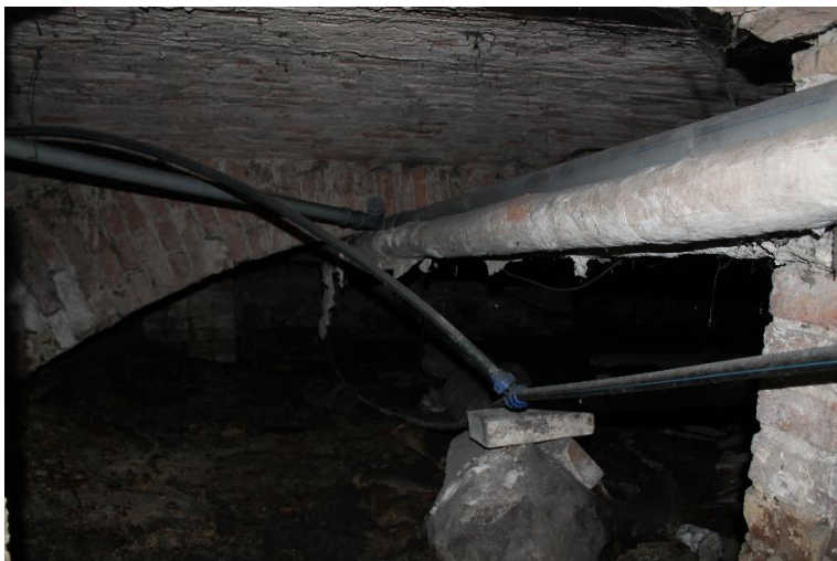
Foto 29. Hoone kesktelge pidi ulatub tänavapoolsesse otsa samuti kelder, millel on telliskividest laotud vahekaared.
