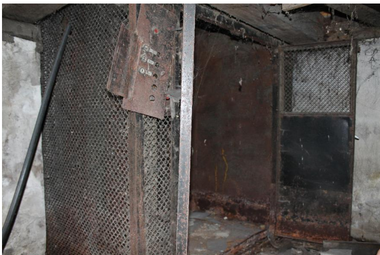
Foto 30. Vana lift, mis viis keldrist teisele korrusele. Ülemistel korrustel on liftišaahh kipsplaatidega kinni ehitatud.
