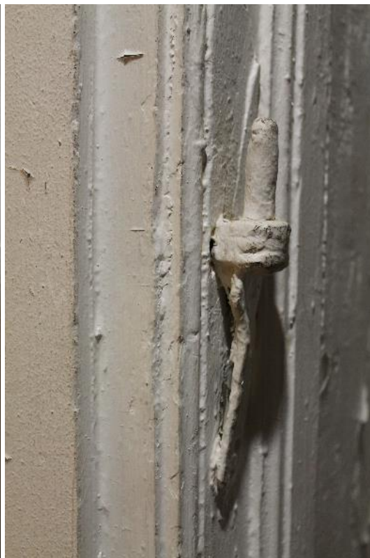
Foto 56. ukseliist ja säilinud algse uksehinge osa.
