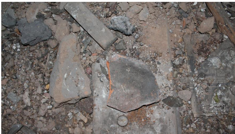
Foto 27. Põõningul leitud keraamiliste plaatide fragmendid. Võimalik, et tegu on algsete katusekividega.
