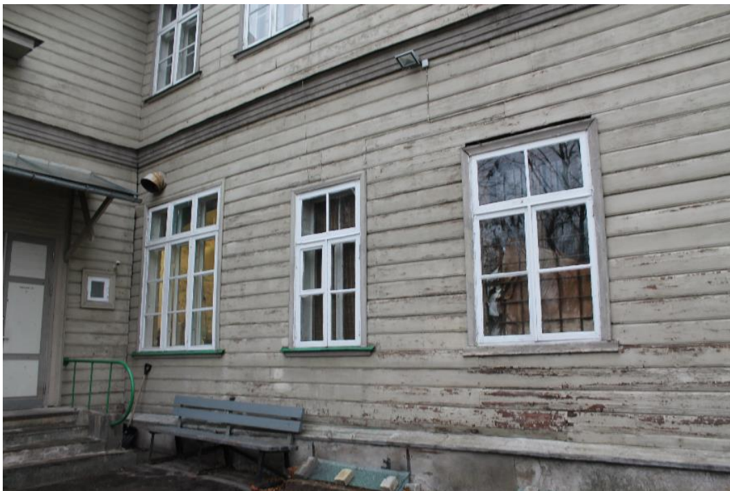
Foto 18. Vaade akendele A21-24. Parempoolne 6-ruuduline aken A21 puudub 1947. aasta plaanilt, kuid kõrval olevad A22-24 on plaanil juba olemas ning on arvatavasti ehitusaegsed.
