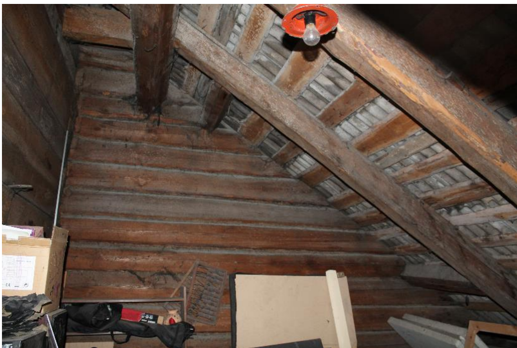
Foto 44. Ruumi 203 kõrval asuv pööningu osa. Otse hoone lääneseina laudist ning vasakul ruumi 202 sein. Laudise laiusest võib järeldada, et ruumi 202 sein on ehitusaegne.
