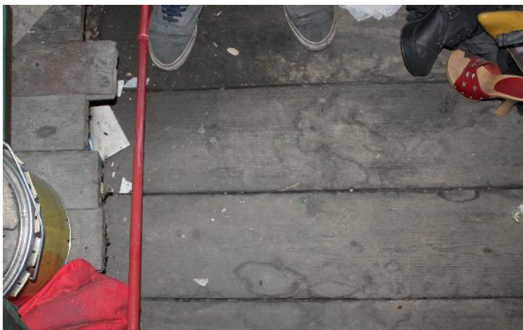
Foto 42. Ruumi 203 asuva pööninguosa põrand. Näha lai alumisi põrandalaudu ning tõstedud kitsaid põrandalaudu toapoolses osas.
