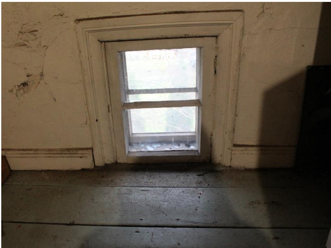
Foto 57. Ruumi 229 säilinud algsed laiad põrandalauad, liistud, räästa all nivendiseina ainuke säilinud aken A46 koos liistudega.
