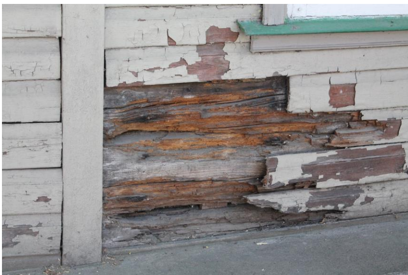
Foto 20. Laudise kadu ning värvi koorumine. Voodrilaua all on näha seinte puitkonstruktsiooni.
