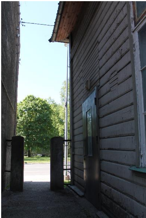
Foto 16. Välisuks VU5, mis on ehitatud akna asemele. Alge akna kohta on näha ukse kohal fassaadil (kitsam laudis).
