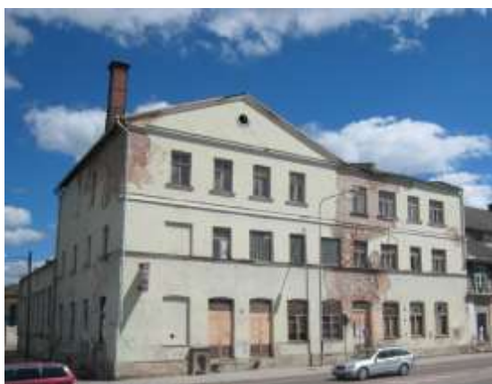
Foto 8. Säiliv endise pärmivabriku peahoone fassaad
