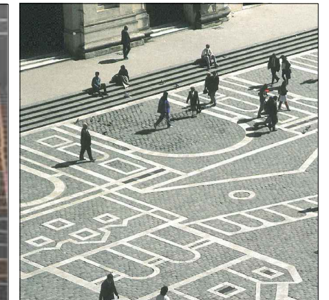
BETONKIVISSE MARKEERIMINE VALATUD BETOONIGA
