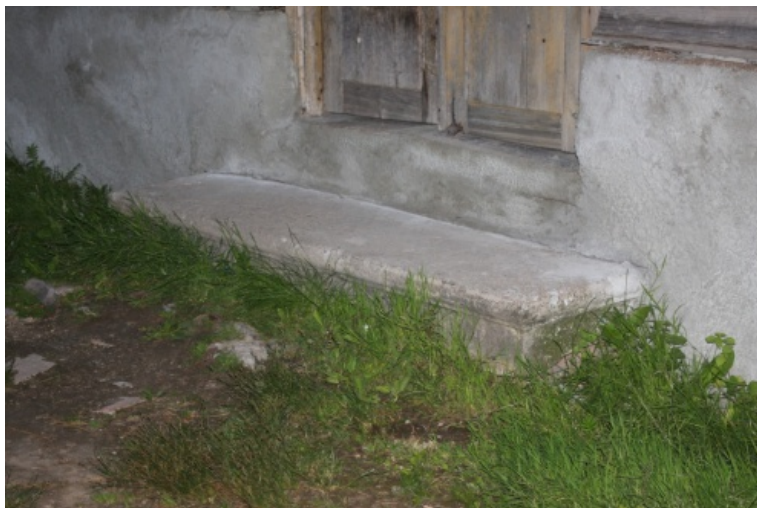
Pilt nr 3. Hea näide betoontrepist Marja 16 peaukse ees. Astme ääred on ümardatud ning faasitud (Nutt 2010).
