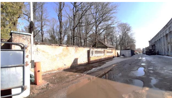
Foto 5 Vaade kalmistu piirdemüürile
