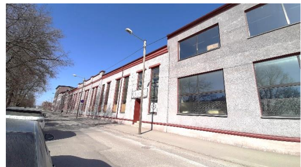
Foto 10 Vaade Peetri 26a hoonele
