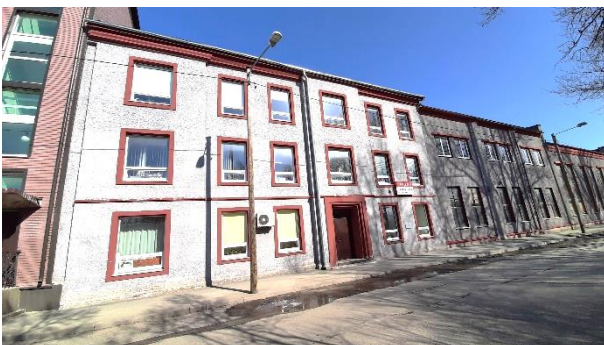
Foto 9 Vaade Peetri 26a hoonele
