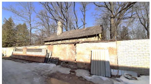
Foto 6 Vaade kalmistu piirdemüürile
