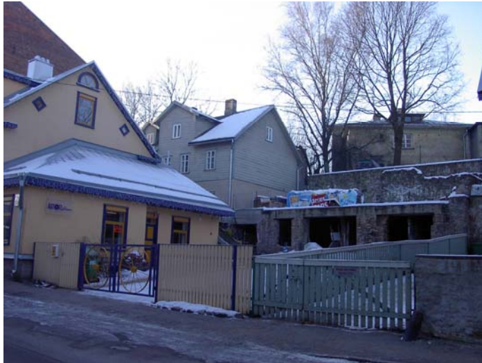
Foto 7 Vaade Tähtvere 6, 8 õuele ( säilinud hoone I korrus ja tulemüüri osad)
