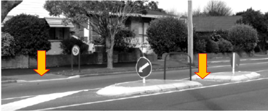
Fotot 3.3.1.3: Kergliiklejale on tagatud sujuvad üleminekud tänavatasapindade vahel, sh ohutussaare ületamine tasapinna muutuseta. Allikas: „Pedestrian planning and design guide“, Land Transport NZ, 2007
