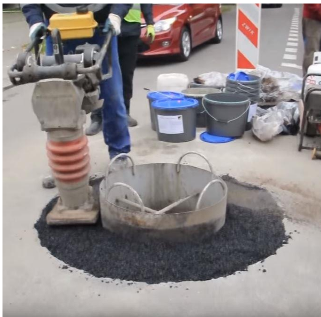
Joonis 5.5 Tampriga tihendamine rakisega.
