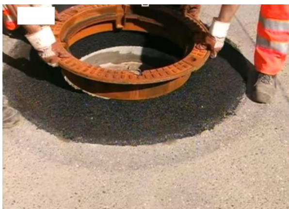
Joonis 5.6 Luugi korpuse paigaldamine
