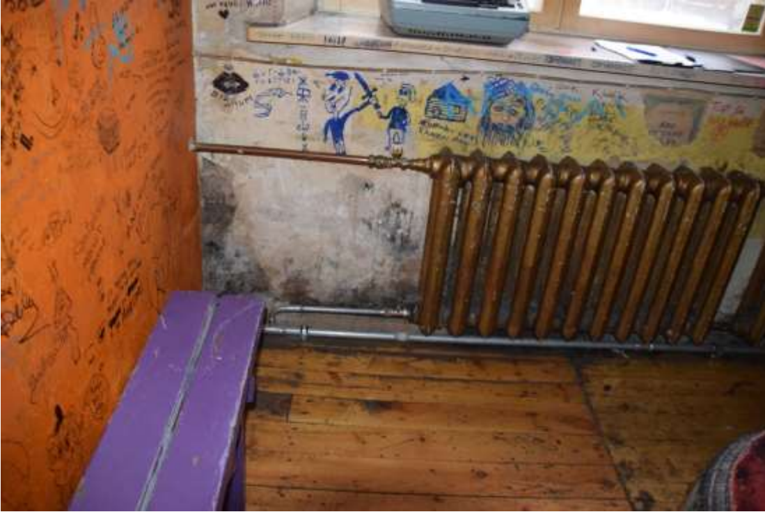
Foto 5. Hallituseente kolooniad suitsunurgas (Lisa 4 Proov 1 võtukoht)
