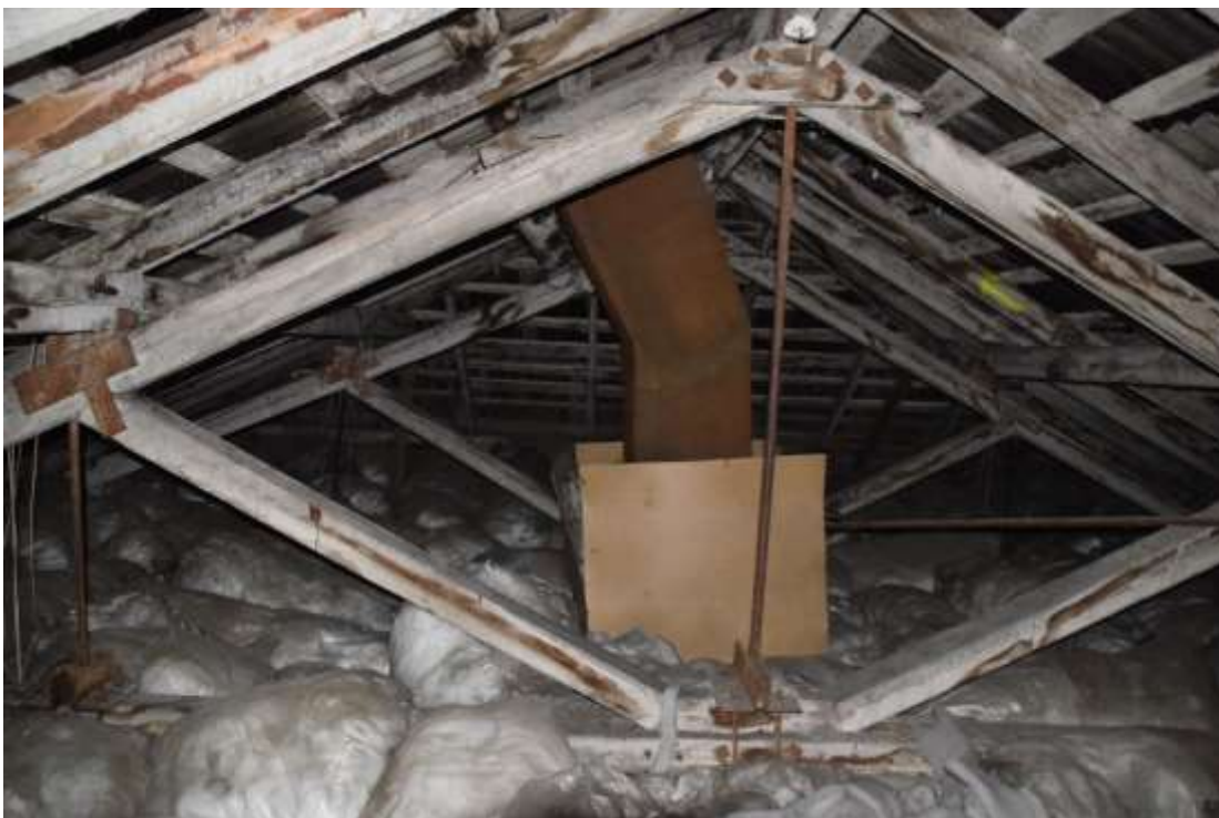
Foto 13. Ebahühtlaselt paigutatud soojustus pööningul
