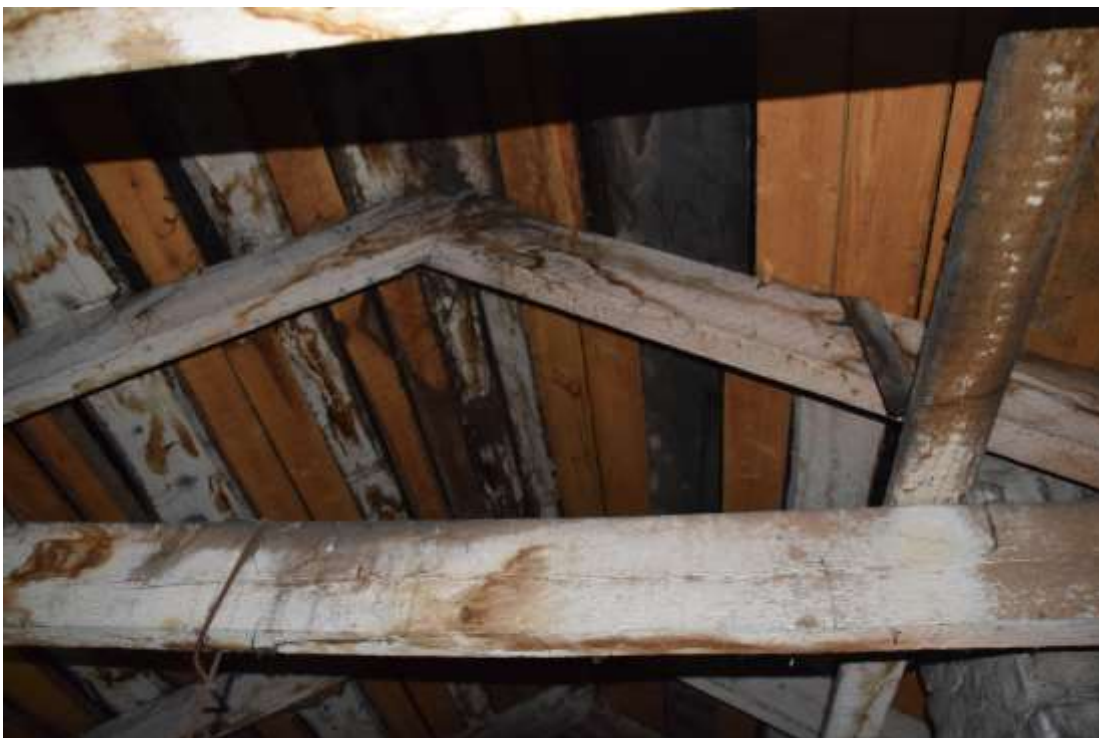
Foto 11. Õhuniiskuse kondenseerumisest tingitud märgumise jäljed pööningul
