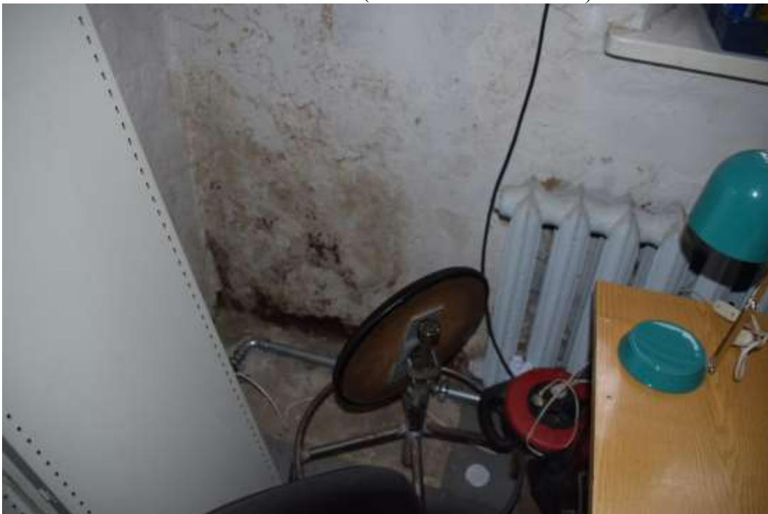
Foto 10. Hallituseente kolooniad kabineti nurgas (Lisa 4 Proov 5 võtukoht)
