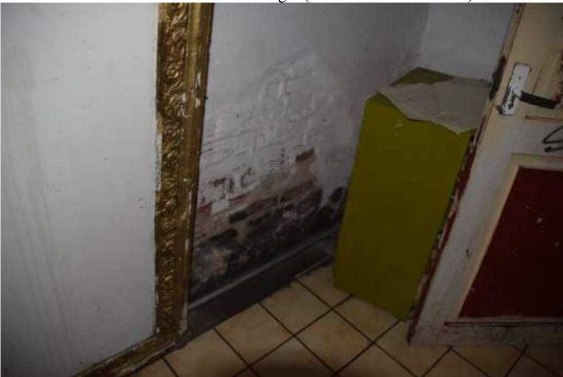
Foto 6. Hallituseente kolooniad vestibüüli nurgas (Lisa 4 Proov 2 võtukoht)
