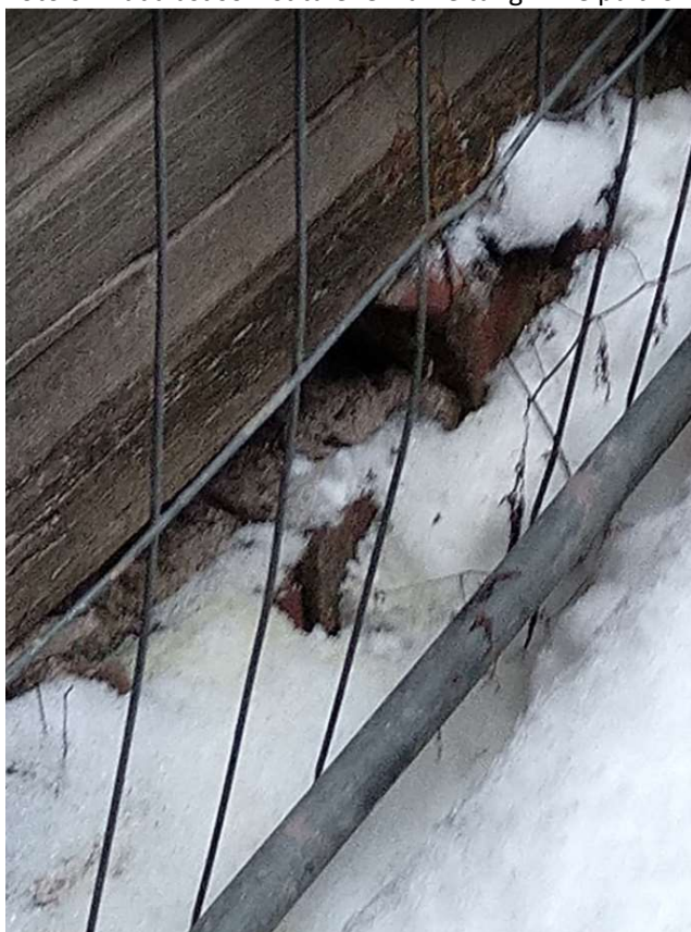
Foto 6: Madalast soklist tulenev lume tungimine puitkonstruktsiooni
