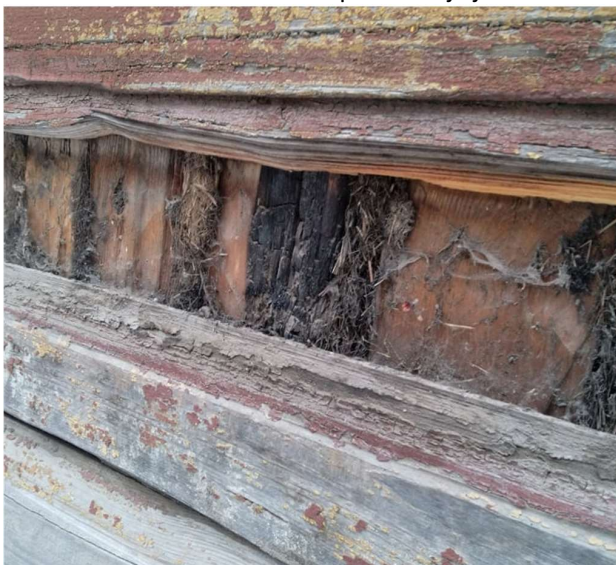
Foto 9: Kandestruktsiooni põlemise jäljed
