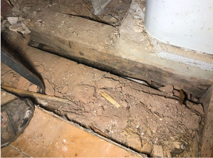
Foto 12: Ahju toetumine vahelaetaladele
