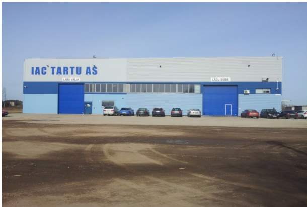
Foto 1: Parkimine hoone lõunaküljel
