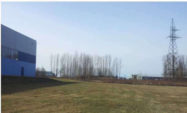
Foto 3: Eleringile kuuluv kõrgepingeliin hoonest põhjas
