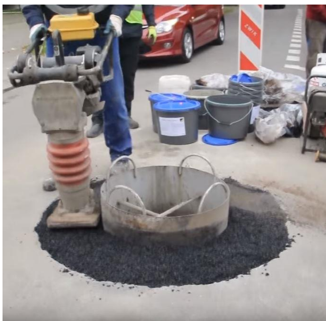
Joonis 5.5 Tampriga tihendamine rakisega.
