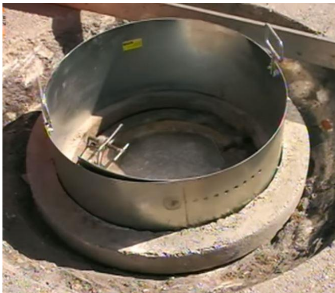
Joonis 5.3 Muudetava suurusega asfaltbetoonsegu tihendamiseks rakis (eemaldatud kaevuraam). Lisaks on näha kate, mis väldib asfaltbetoonsegu, pinnas jne sattumist kaevu. Kate eemaldatakse pärast asfalteerimist.
