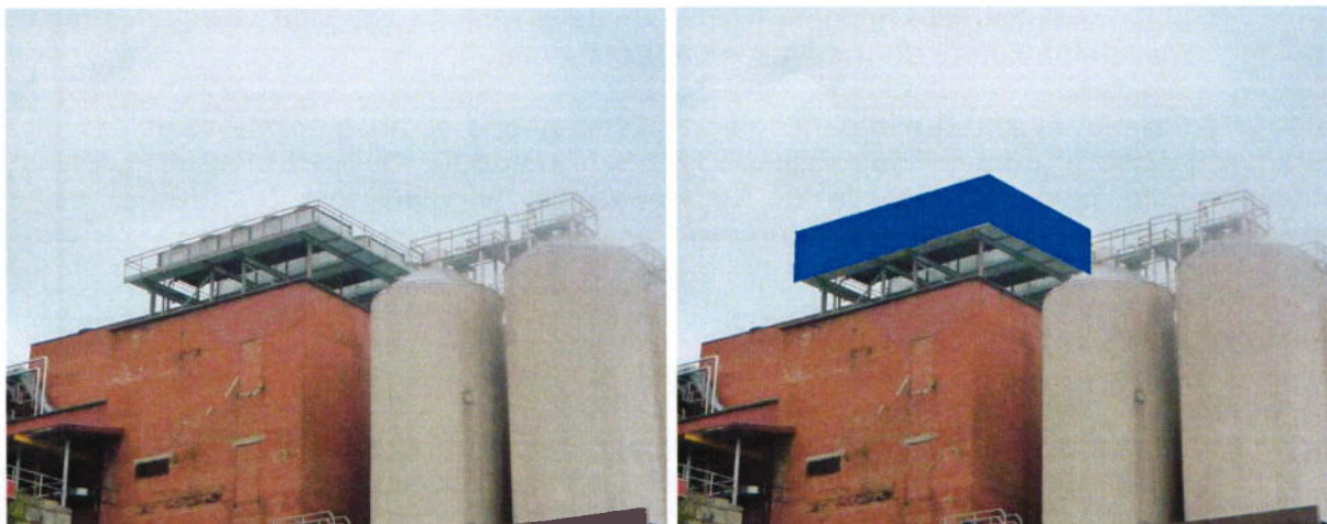
Joonis 5. Üks võimalik tehnoseadmetes lähtuva müra leviku piiramise võimalus (illustratiivne joonis).
