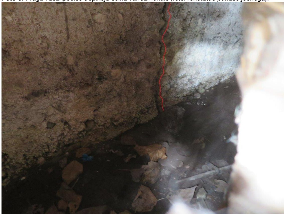
Foto 8: Pragu vasakpoolse trepikoja seina vundamendis (fotol rõhutatud punase joonega).
