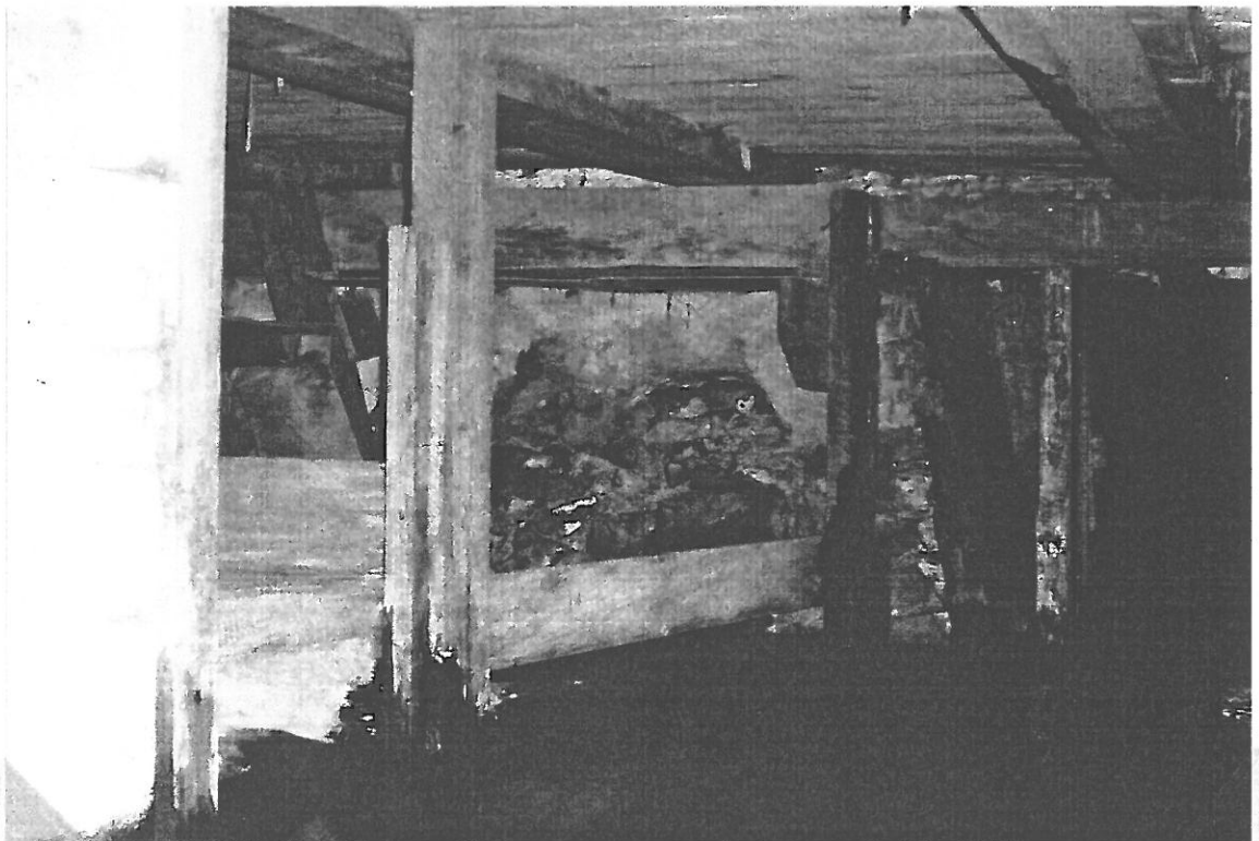
VAADE - VAHESEINÄÄLUNE VUNDAMENT FOTO NR 6
