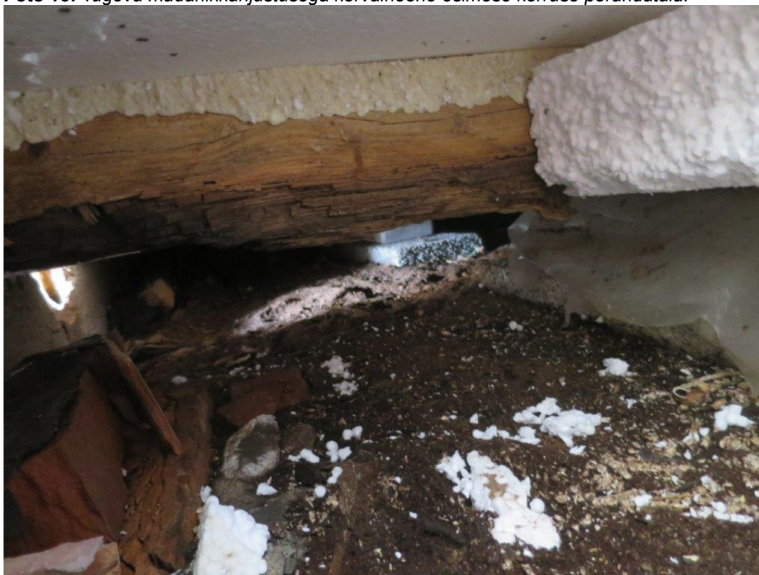
Foto 13: Tugeva mädanikkahjustusega kõrvalhoone esimese korruse põrandatala.
