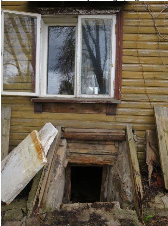
Foto 16: Peahoone hoovist keldrisse sissepääs. Näha mädanikkahjustusega palgid.
