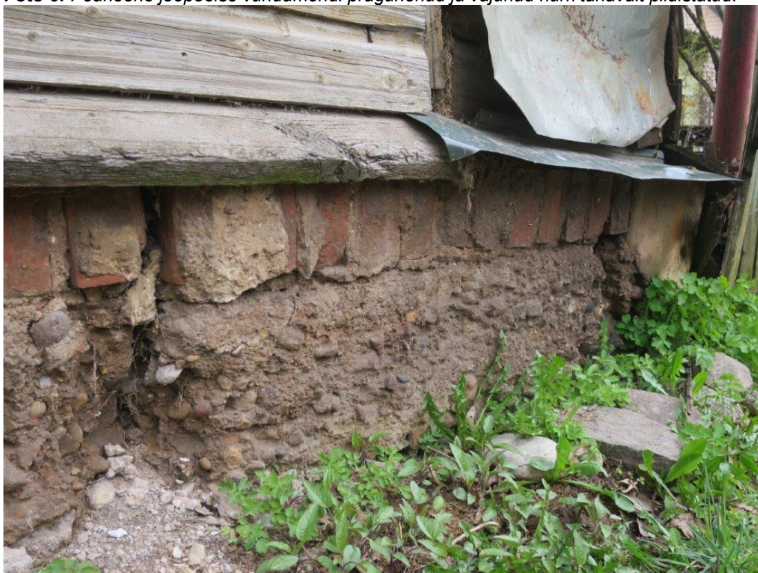
Foto 6: Peahoone jõepoolse vundamendi pragunenud ja vajunud nurk tänavalt pildistatud.
