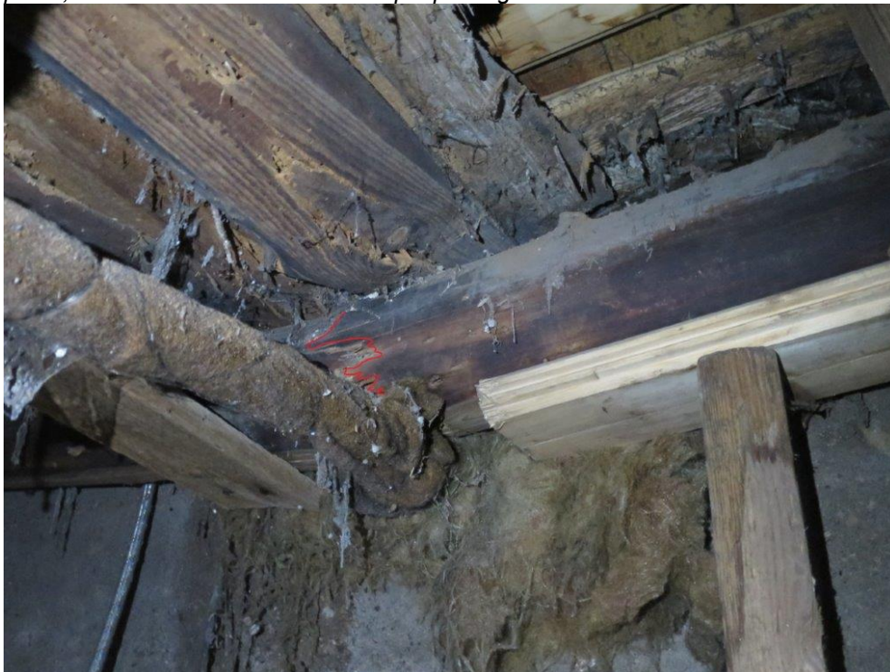
Foto 12: Murdunud keldri vahelae tala. Toetub murdunud osaga olemasoleva toru peale, selle kõrvalt on tala toetatud puitprussiga.
