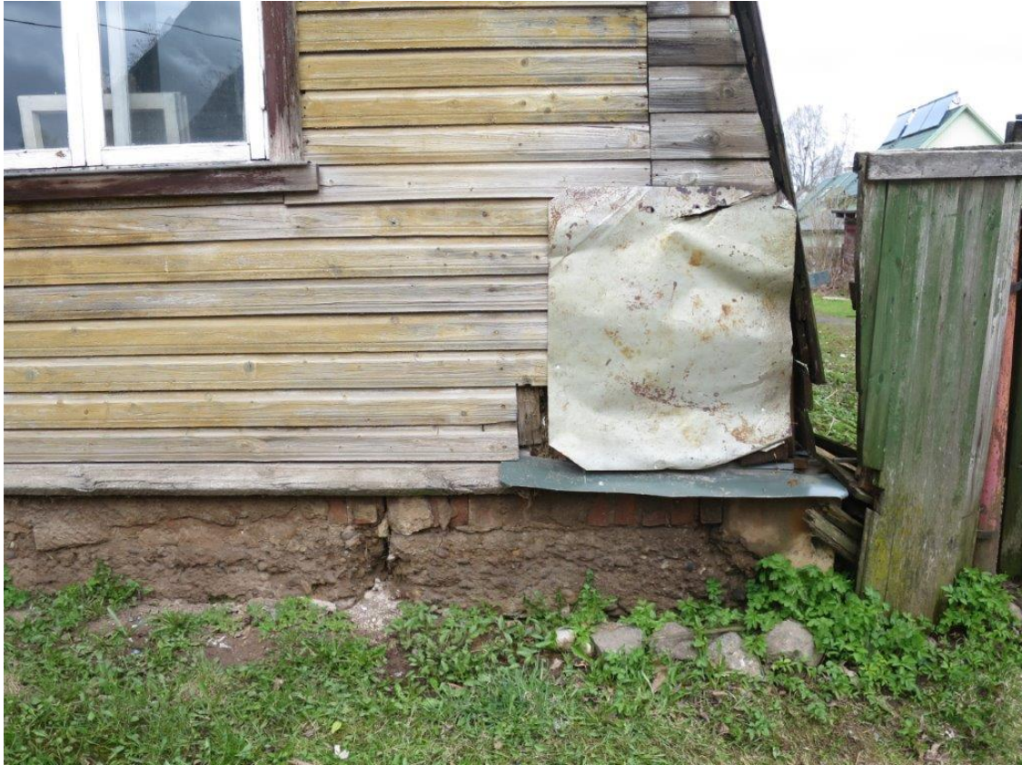
Foto 4: Peahoone sokli eenduv osa on kaetud originaalis puidust veelauaga, mis on tänaseks amortiseerunud. Veelaud on osaliselt asendatud plekiga. Näha on ka pragunenud jõepoolne vundamendi nurk.
