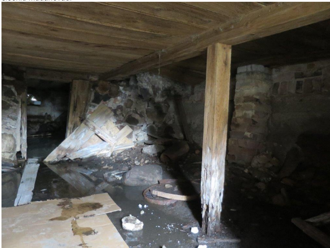
Foto 17: Peahoone madal kelder suunaga tänava poole. Paremal tulemüüri vundament, keskel hoone keset läbiva kandeseina vundament. Põrand on osaliselt vee all, tagumise ruumi põrand rohkem. Olukord on sage, sest pinnasevee tase on pidevalt kõrge. Puitkonstruktsioonid mädanevad.
