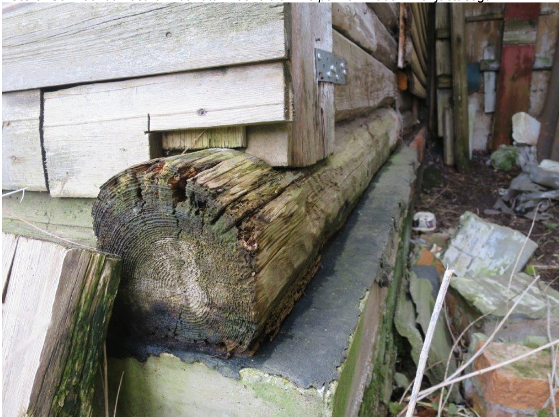
Foto 5: Sokli eenduv osa on katmata. Hoone alumine palk on mädanikkahjustusega.
