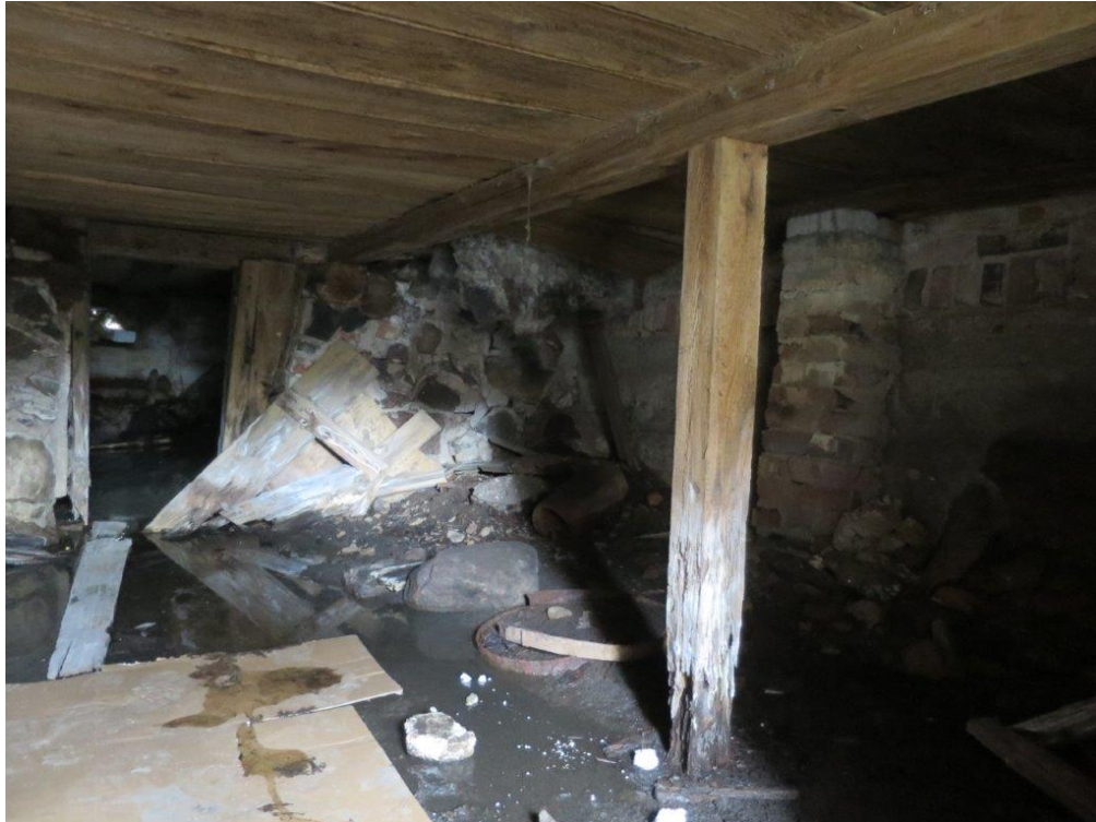
Foto 10: Näha on vesi keldri põrandal ja alt läbi mädanenud vahelae tala tugipost. Näha ka hoone keskmise kandeseina vundament. Paremalt on tule müüri vundament.
