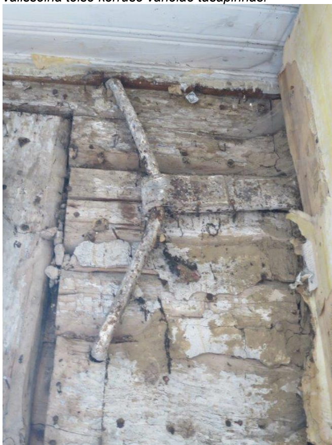
Foto 9: Pinge all olev tule müüri ankur tänavapoolse välisseina teise korruse vahelae tasapinnas.
