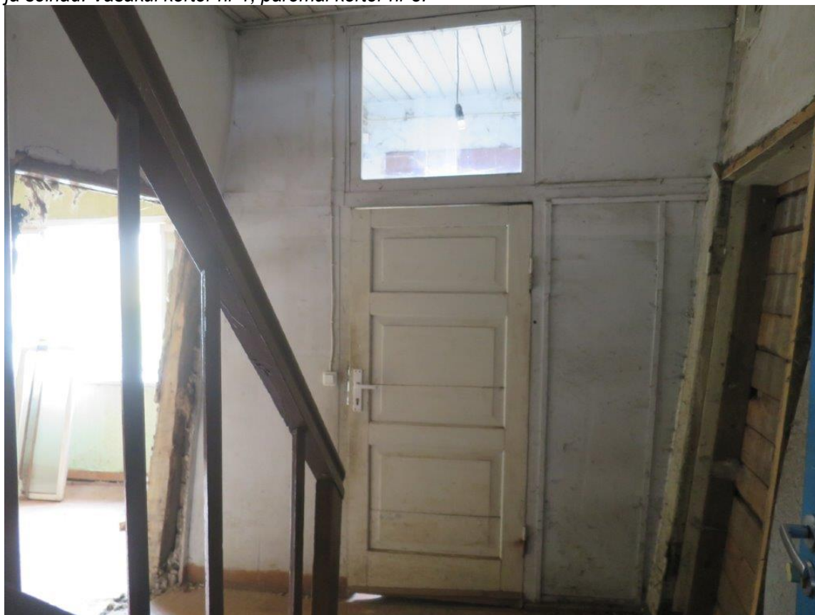
Foto 9: Peahoone trepikoda suunaga välisukse poole. Fotol näha tugevalt kaldu olevad trepikoja ja seinad. Vasakul korter nr 1, paremal korter nr 3.
