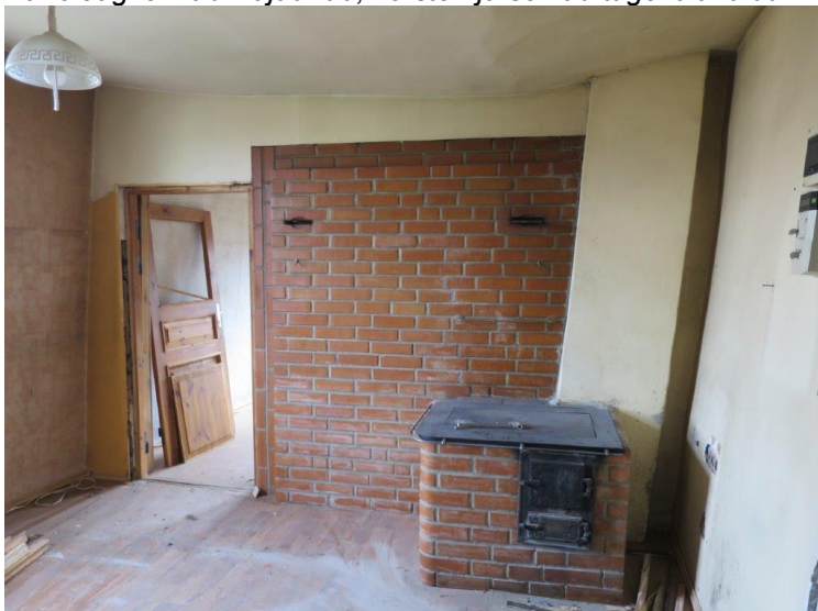
Foto 13: Peahoone teise korruse korter nr 5 hoovipoolne tuba. Vaheleagi on läbi vajaanud, korsten ja seinad tugevalt kaldu.
