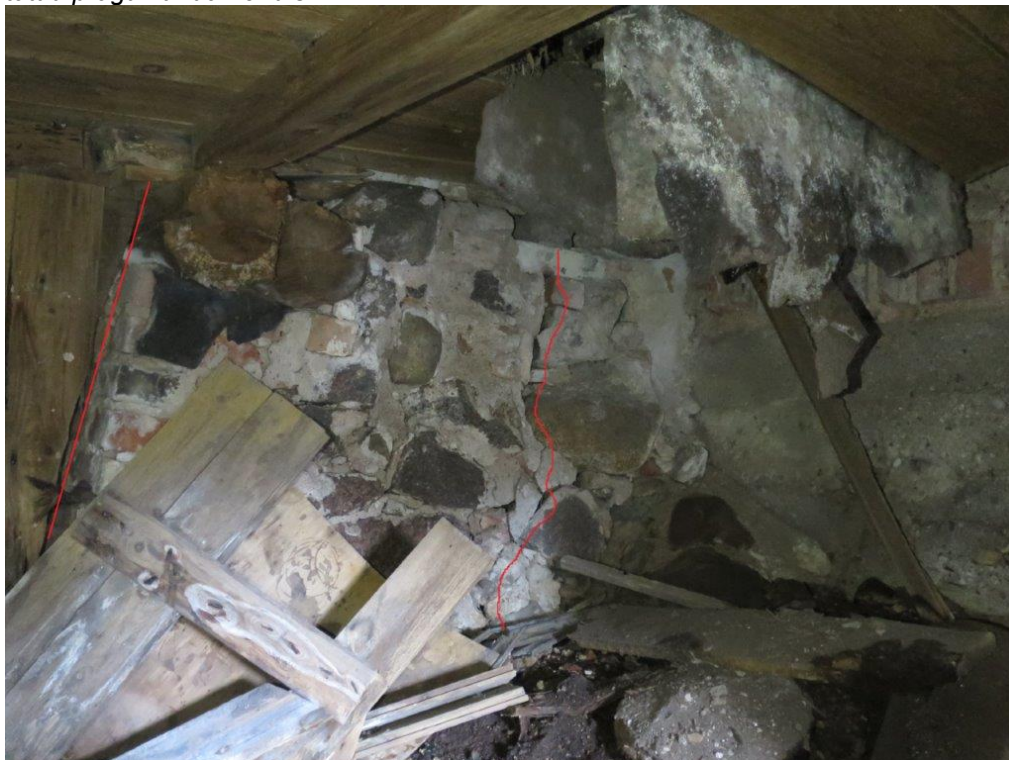
Foto 11: Foto peahoone keskmise kandeseina vundamendi liitumisest tule müüri vundamendiga. Vasakul punase joonega rõhutatud kalle, paremalt punase joonega rõhutatud pragu vundamendis.
