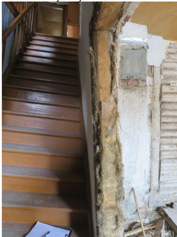
Foto 8: Peahoone trepp teisele korrusele. Ukseavast paremal korter nr 1. Konstruktsioonid on vajunud ja kaldu.
