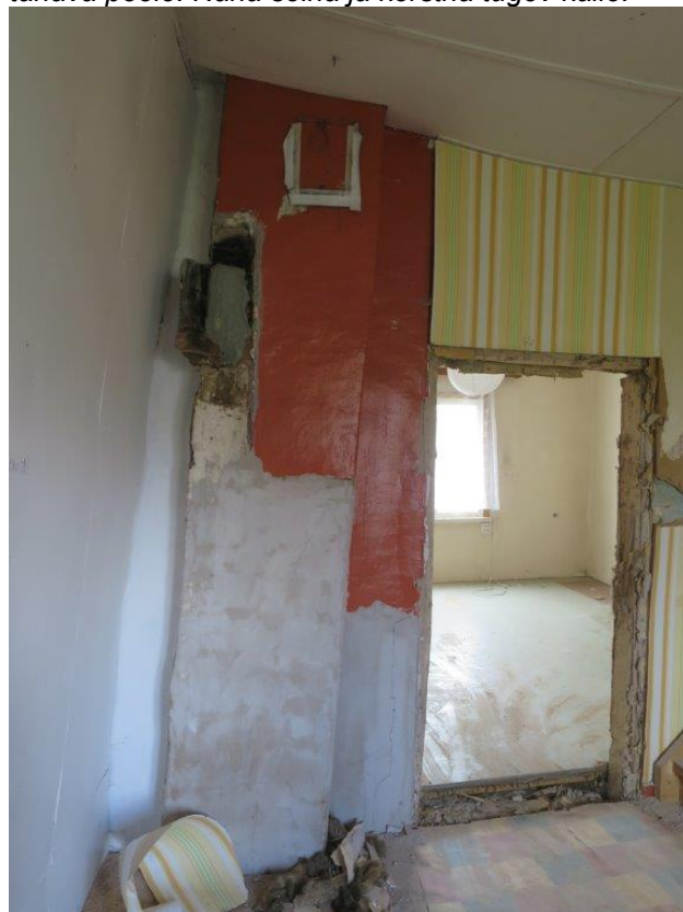
Foto 11: Peahoone korteri nr 3 ruumid suunaga tänava poole. Näha sein ja korstna tugev kalle.
