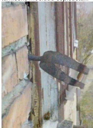
Foto 5: Vihmaveetoru kinnitamiseks mõeldud sepsidetail.
