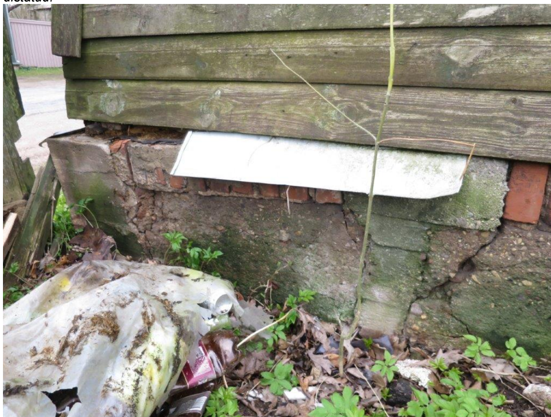
Foto 7: Peahoone jõepoolse vundamendi pragunenud ja vajunud nurk sissepääsu juurest pildistatud.
