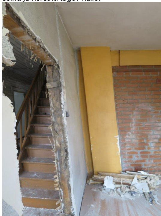
Foto 12: Peahoone teise korruse korter nr 5 tänavapoolne tuba vaatega trepikotta. Näha sein ja korstna tugev kalle.
