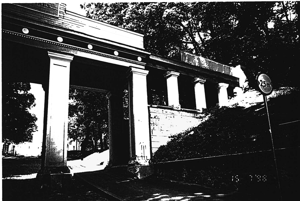
Foto 1.1. Vaade Inglisillale Lossi t. poolt enne tööde algust (puudub pürde üks seksioon).
