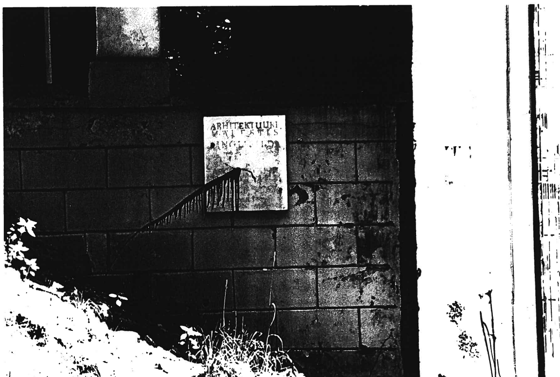
Foto 1.4. Koorduvate värvikihtide ja värvimäärdumistega rustikapind.
