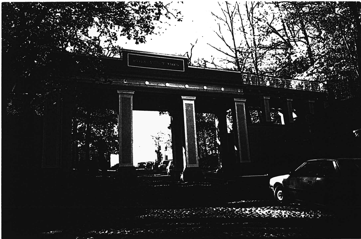
Foto 1.17. Vaade sillale Lossi t. poolt pärast tööde teostamist.
