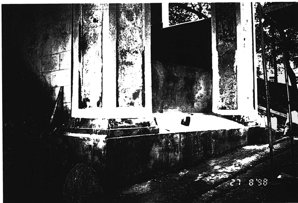
Foto 1.10. Vanadest värvikihtidest puhastatud ja remonditav soklipind
