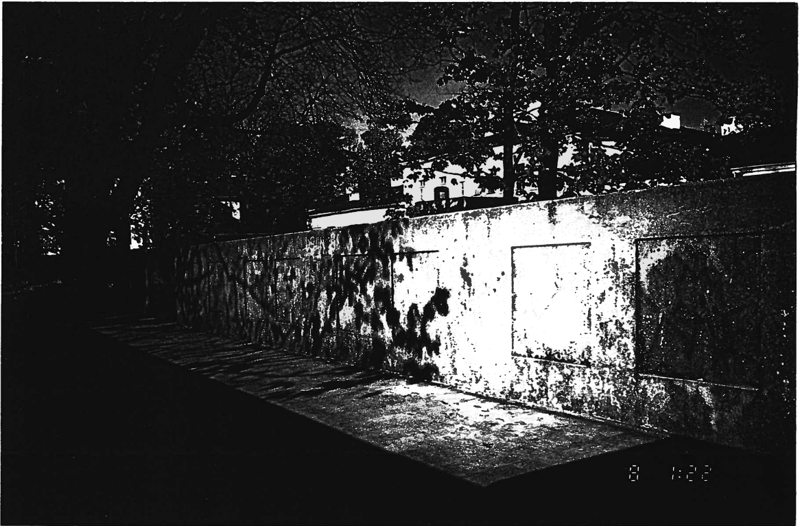
Foto 2.5. Saneerimiskrohviga konserveeritud pind (kasseti keskosas).
