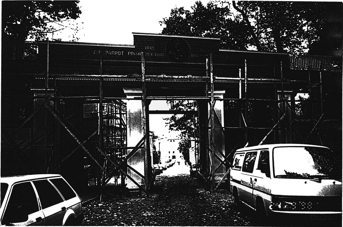
Foto 1.15. Vaade sillale Toomemäe poolt tööde lõpustaadiumis.
