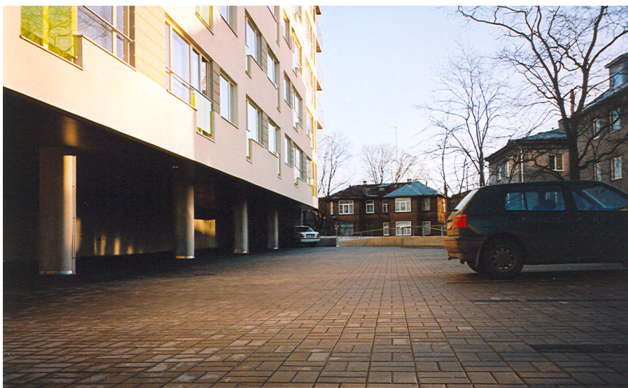
Foto 7. Elamu- ja büroohoone Ravi tn 23. Maa-aluse garaaži katusel paikneb parkla.
