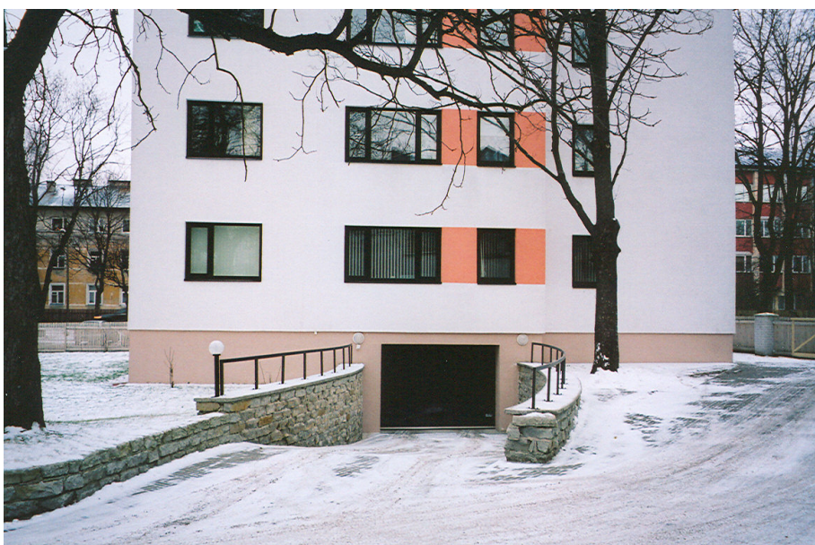
Foto 10. Elamu Pärnu mnt 289 Nõmmel. Garaaži sissesõit tänavaga risti paikneva hoone tagaküljel. Keldrikorrusel põiksuunalised r/b raamid.
