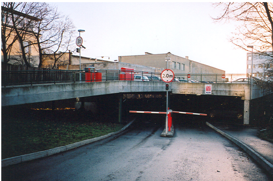
Foto 21. Liivalaia tn 8. Hansapanga õu. Kahetasandiline suhteliselt odav parkla. Postide samm 7,5 x 17m. Laepaneelide h = 400\text{mm} .
