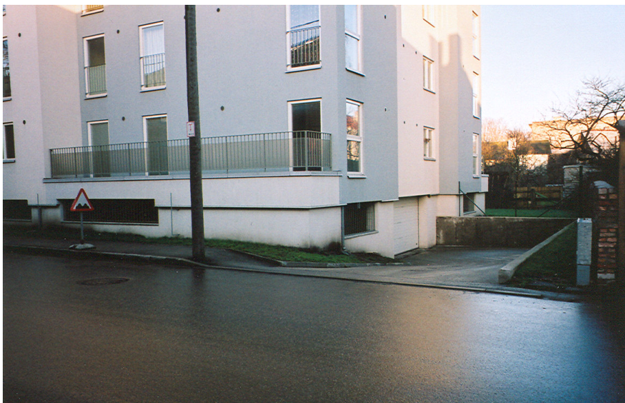
Foto 9. Elamu Veerenni tn 19. Sonnel tõstetud, sissesõit lauge. Garaaži värav on 4 m lai. Ventilatsioon läbi trellitatud “keldriakende”.
