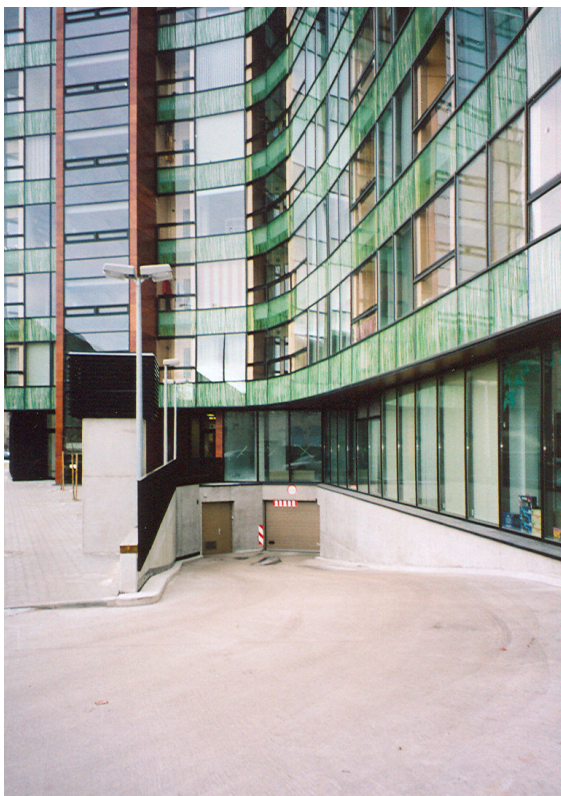
Foto 5. Lootsi tn elamu-büroohoone all on kahekorruseline maa-alune garaaž (D-terminaali juures).
