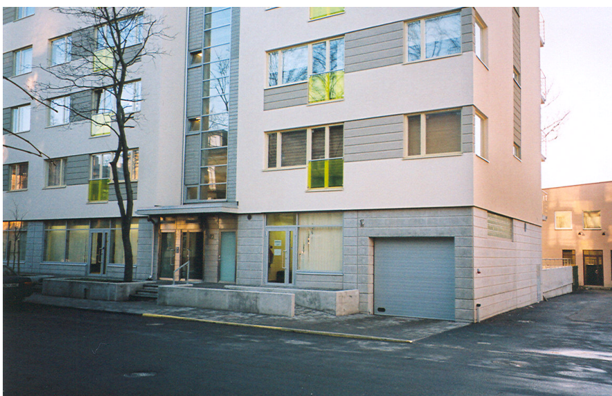
Foto 8. Ravi tn 23. Sissesõit maa-alusesse garaaži.
