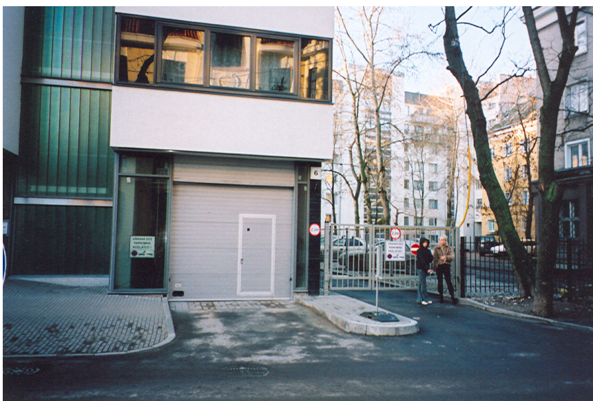
Foto 6. Kaupmehe tn 6 paikneva 8 korruselises elamu- ja bürooones on 109 korterit ja 90 parkimiskohta. I korruse tasandil on bürood ja maa-aluse garaaži väravad. Maapinna tasandil paikneva garaaži sissesõit toimub maja otsaseintes paiknevate väravate kaudu. Lift ühendab kõik korrused.
