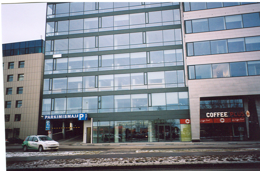
Foto 3. Admirali maja Ahtri tn. Nelja korruseline parkimismaja on tänava poolt varjatud. Kaldtasapindadega kolmerealine parkimismaja vasakpoolses reas tähistavad 5m sammuga postid parkimist. Võrreldes Rävala pst. parkimishoonega halb konstruktiivne lahendus.
