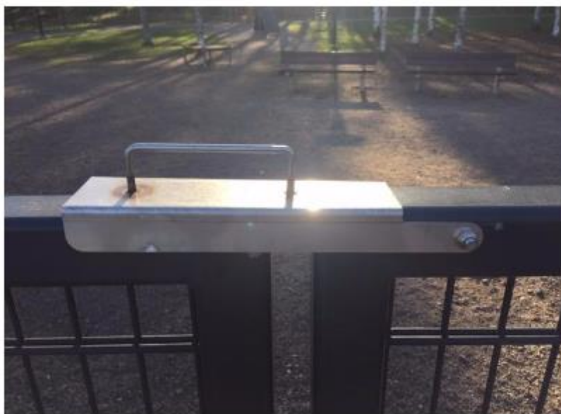
Tiibvärava avanemismehhanism, Helsingi (Foto: Mart Suurkask)
