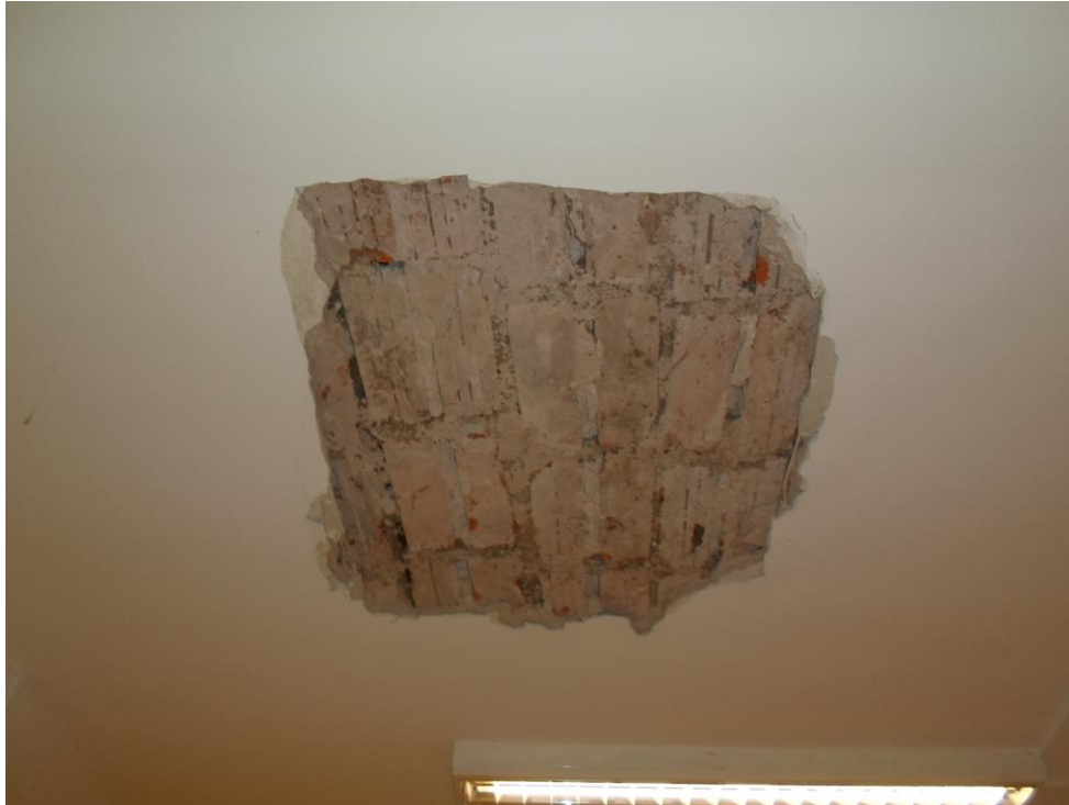
Foto 1: Armatuurvardad on telliste vahel ja enamasti kaetud betooniga
